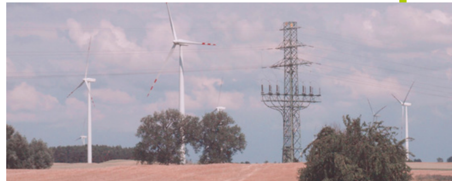
Enea Operator, Linia wysokiego napięcia 110kV Morzyczyn - Drawski Młyn
