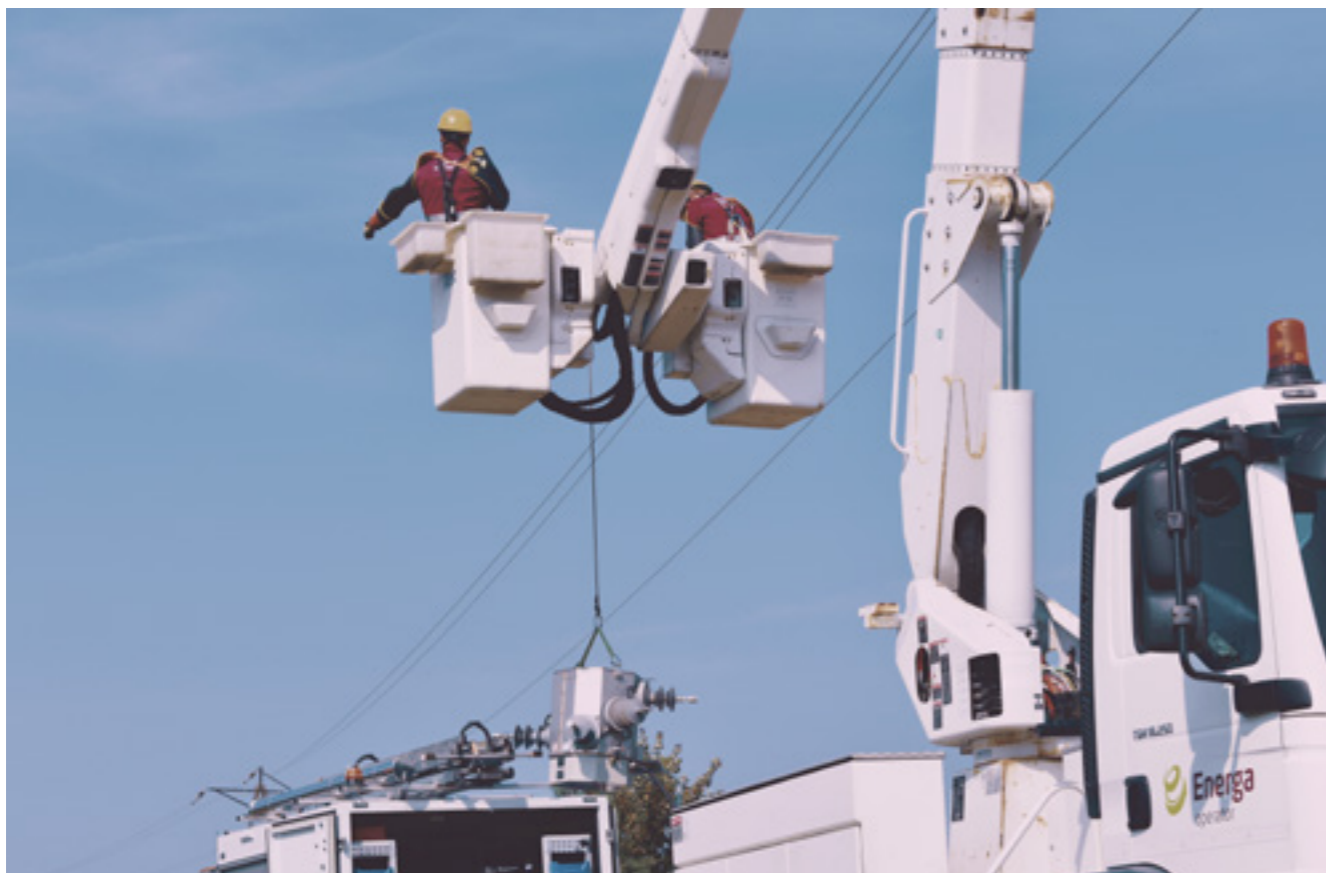
Energa Operator, Modernizacja sieci w Siarzewie
