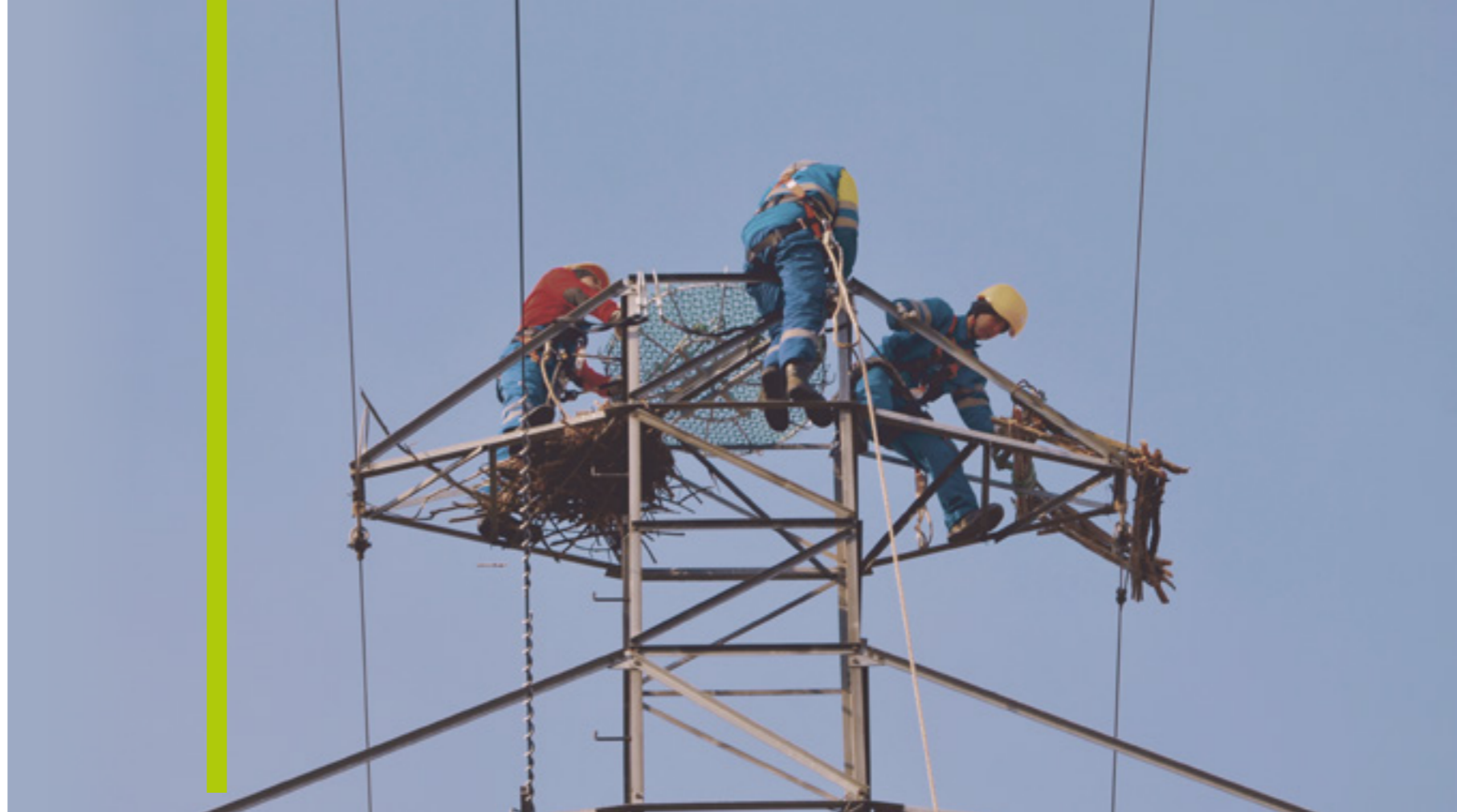
Enea Operator, Budowa platformy na gniazdo rybotów
